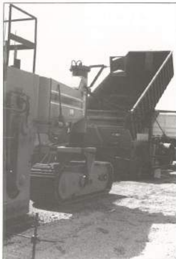
FOTO 7. Vertido en obra.
