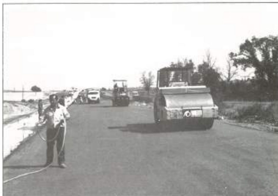
FOTO 15. Compactación del material.
