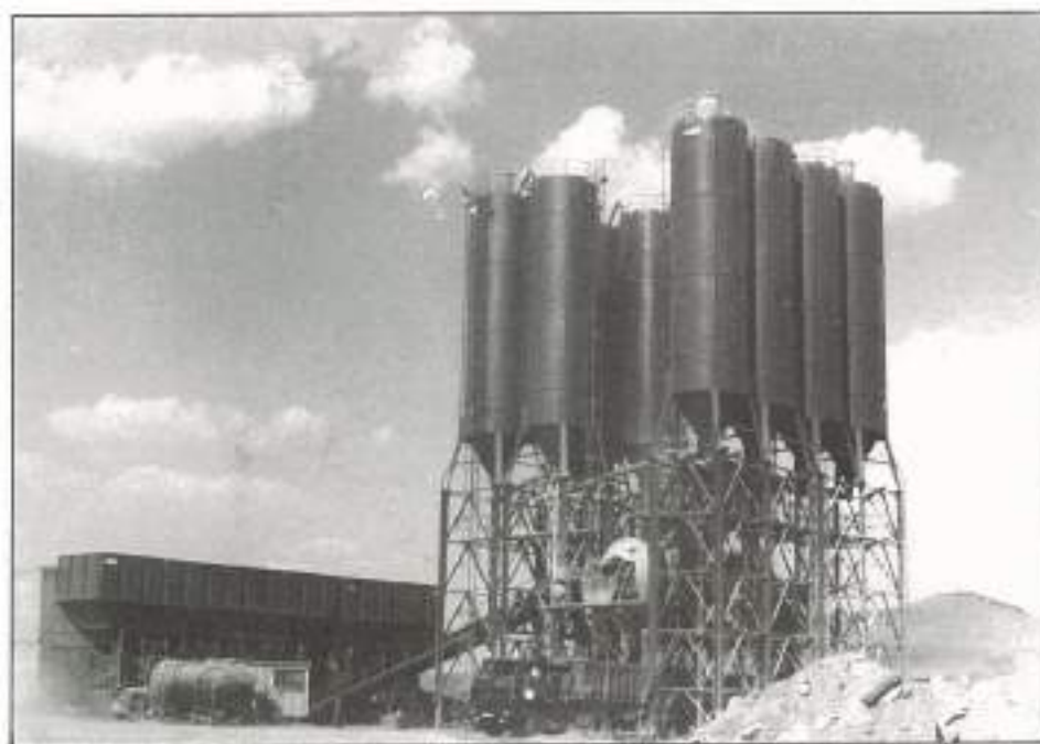
FOTO 1. Planta de hormigonado.
