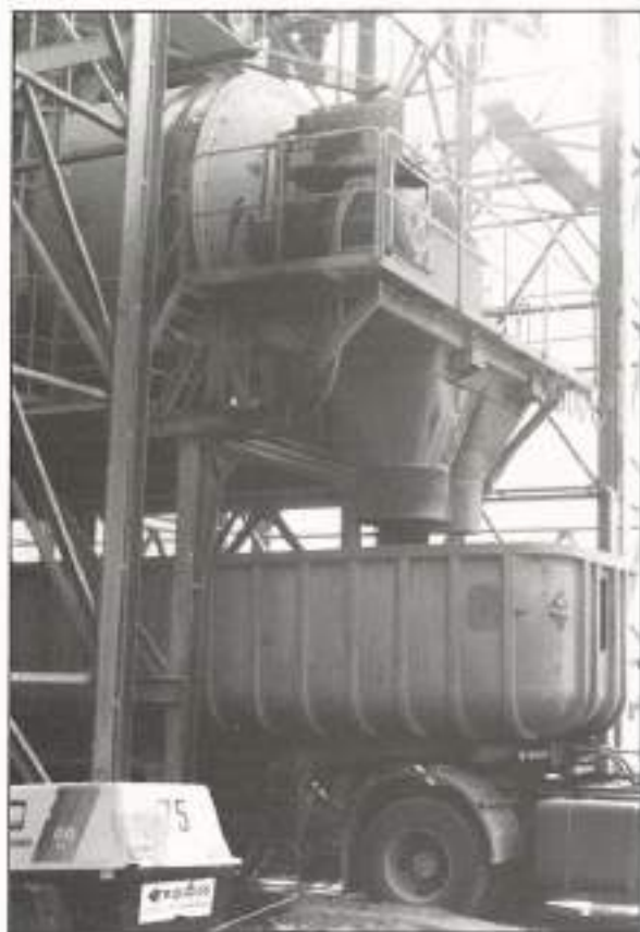
FOTO 6. Vertido sobre camión volquete.
