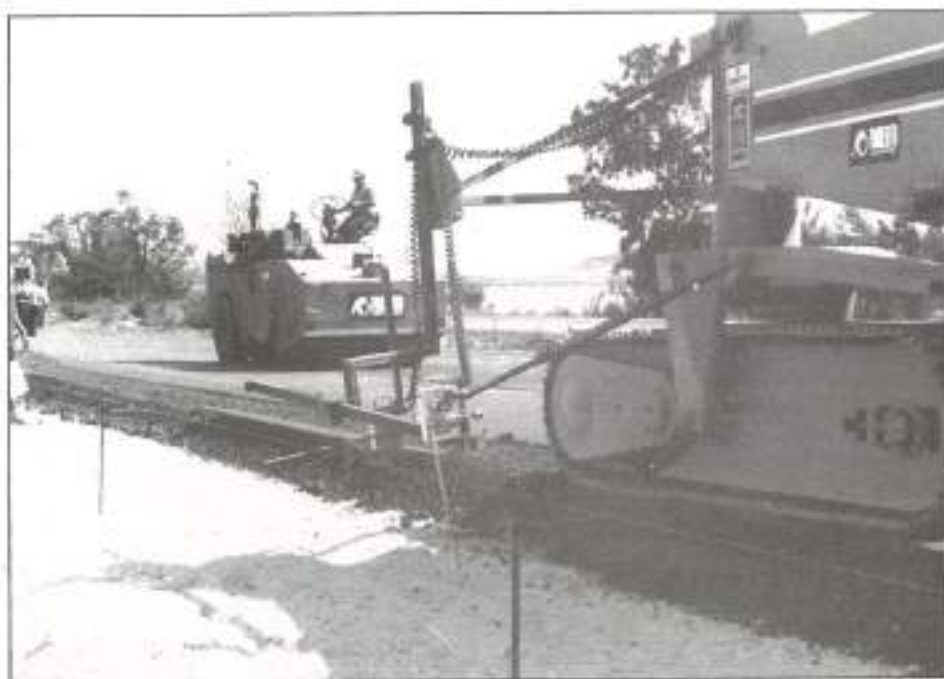
FOTO 14. Detalle del sistema de guado del equipo de extendido.
