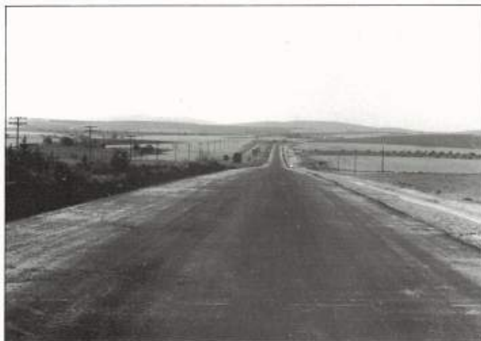
FOTO 17. Unidad de obra acabada.
