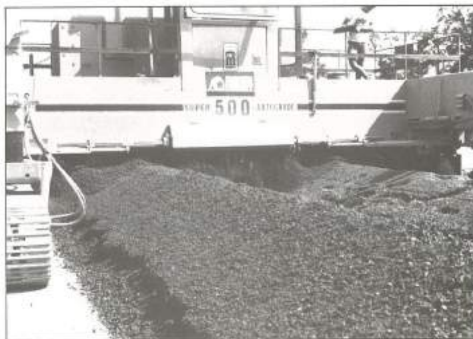
FOTO 10. Equipo autogrado de extendido.
