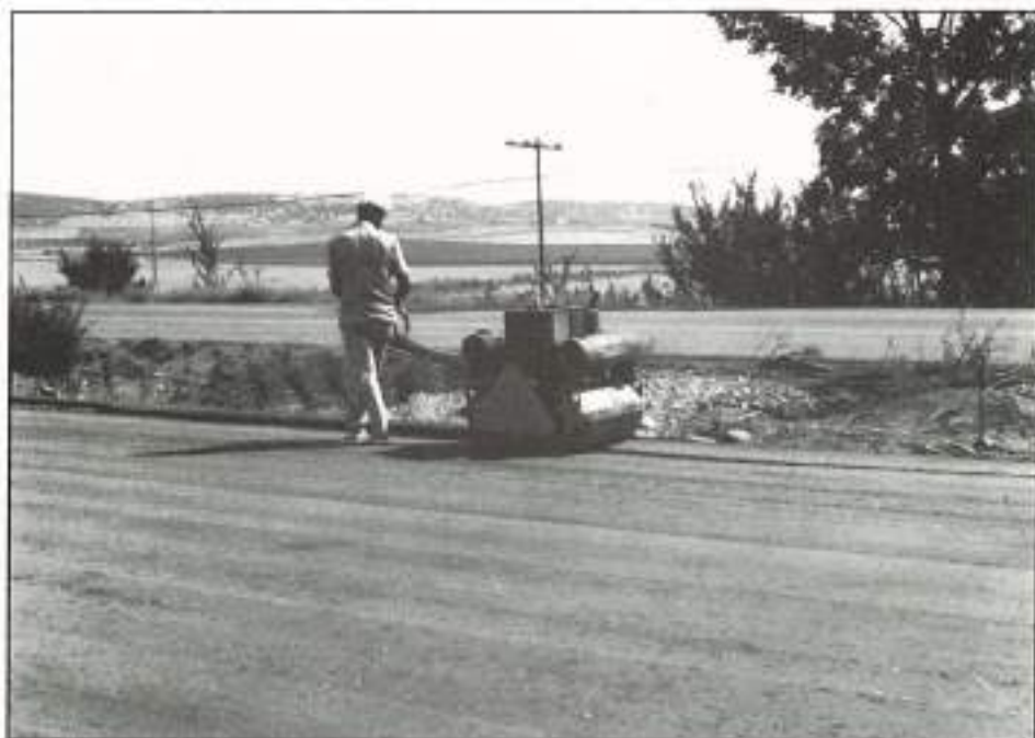
FOTO 16. Detalle del acabado de bordes.
