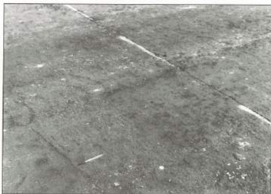
FOTO 20. Junta de retracción producida por un serrado tardío.
