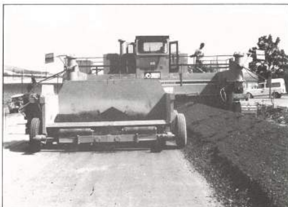
FOTO 8. Sistema de reparto del material.
