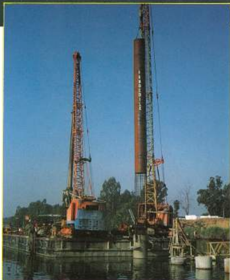
Cimentación mediante pilotes entubados de \varnothing 1.000 mm y \varnothing 1.200 mm y 35 mm de profundidad para la construcción del puente levadizo de la dársena de Alfonso XIII. Sevilla.
