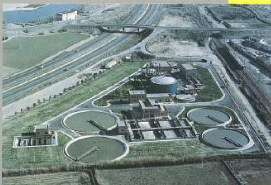
Depuradora de Almozara (Zaragoza).
