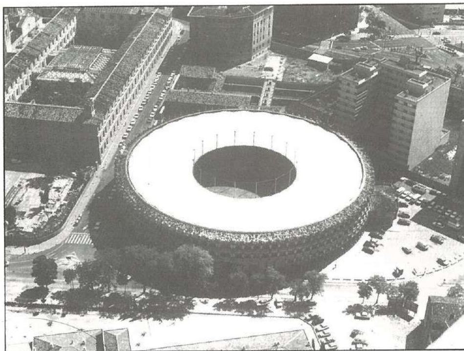
FIGURA 17. Plaza de toros de Zaragoza con su cubierta.
