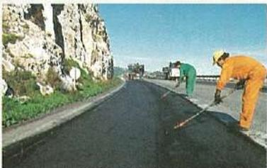
Carpeta asfáltica aplanada con rodillo en caliente sobre un pavimento envejecido (con y sin capa compensadora).
