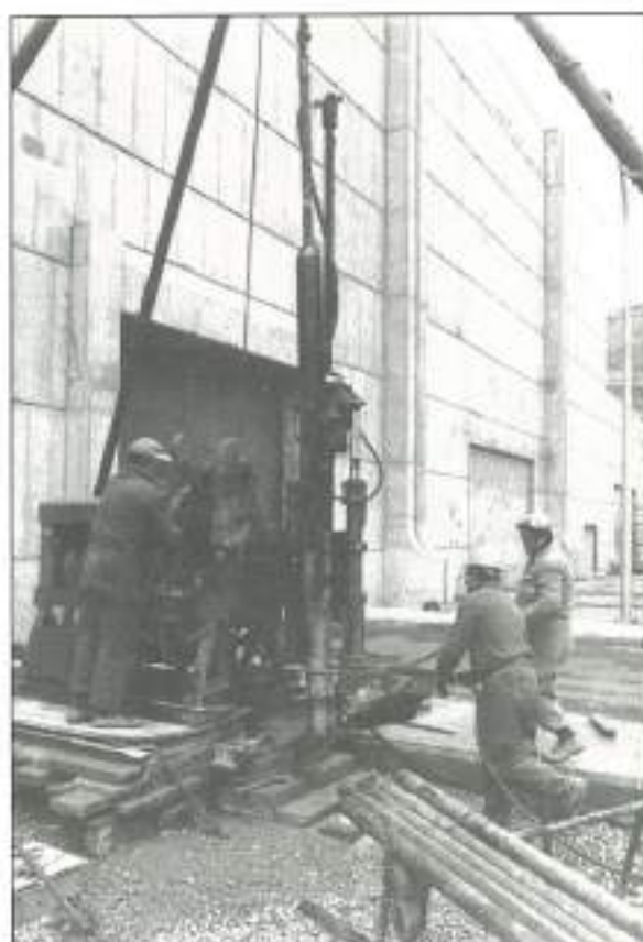
FIGURA 5. Equipo utilizado en la perforación de los sondeos.
