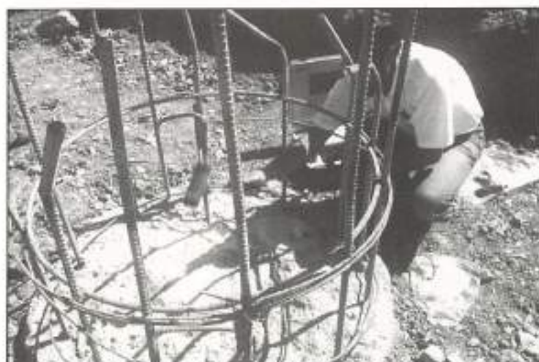
FIGURA 9. Realización del ensayo de impedancia mecánica.
