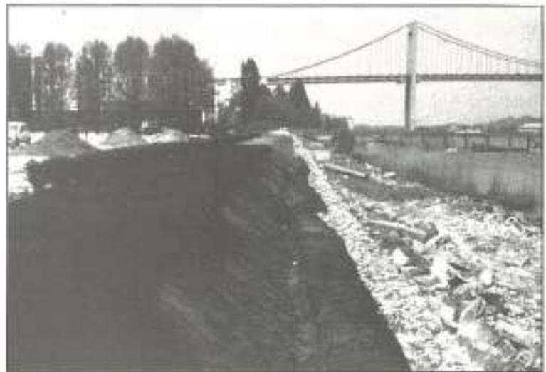
**FOTO 16.** Protección de márgenes con un geotextil. Colocación.
