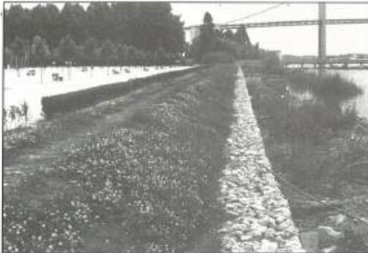
**FOTO 17.** Protección de márgenes con un geotextil. Situación transcurrido cierto tiempo desde su colocación.
