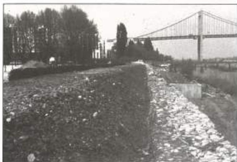
**FOTO 15.** Protecci n de m rgenes con un geotextil. Situaci n antes de colocarlo.
