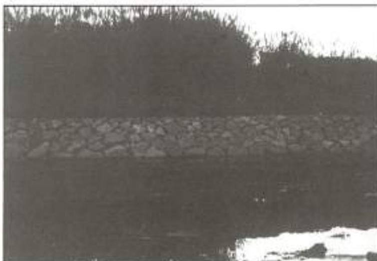
FOTO 10. Río Magro. Protección de una margen con esollera IC. H. Júcar.
