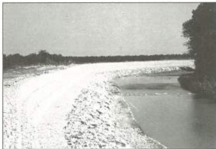
FOTO 11. Río Magro. Protección de una margen con gaviones IC. H. Júcar.
