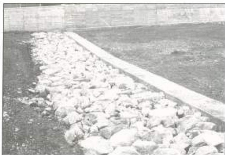
FOTO 7. Umbral de fondo. Escollera y hormigón. Deraña Junta de Aguas de Cataluña.
