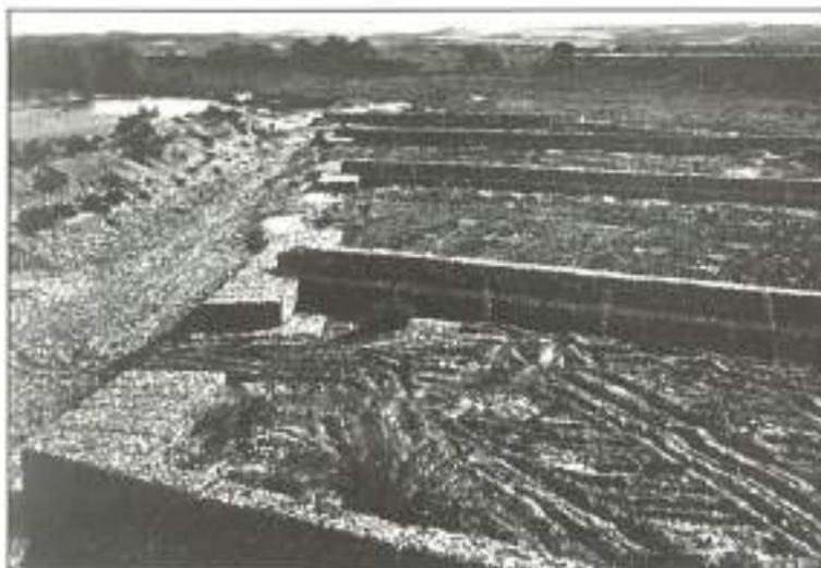
FOTO 12. Protección de una margen. Espigones de gaviones (A. Bianchi, Ingeniero, S. A.).
