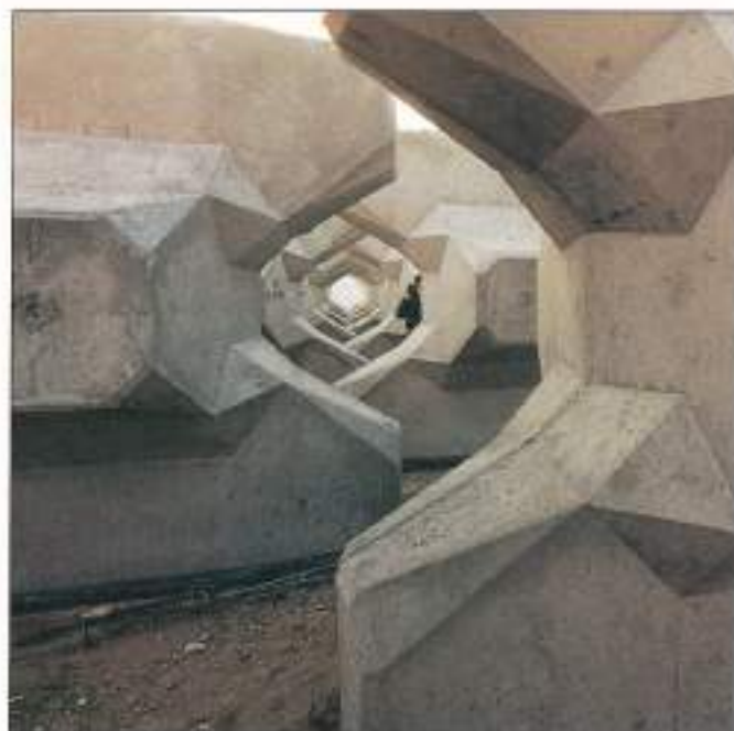
Bloque de 22 toneladas utilizado para la protección del nuevo puerto deportivo de Palamós (Cataluña)
