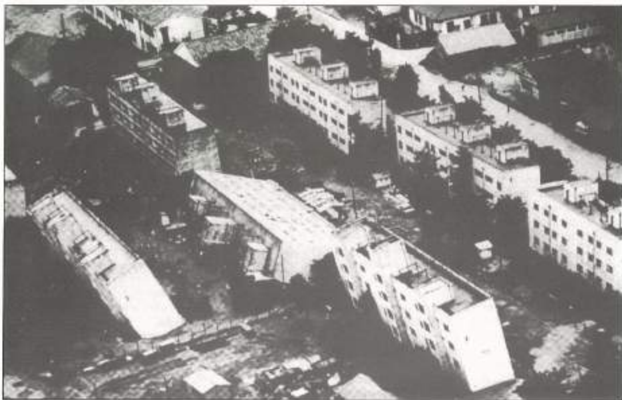
FIGURA 1. Uvicelación de suelo y colapso de edificios en Niigata, Japón, 1964.
