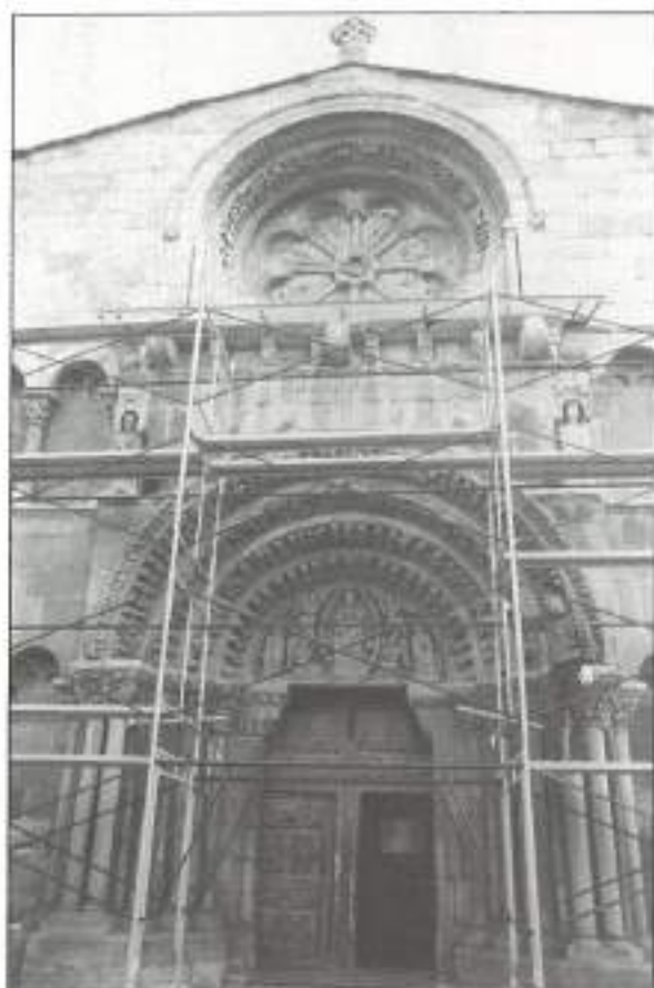
FIGURA 5. Aspecto parcial de la fachada de la iglesia de Santo Domingo (Soria).
