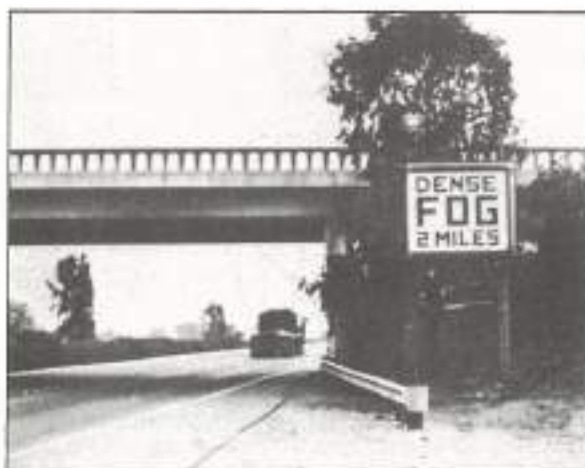
FOTO 11. Señal de matriz de plaquetas electrostáticas.
