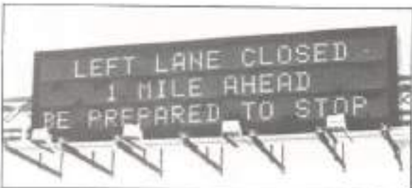
FOTO 9. Señal de matriz de discos electromagnéticos.
