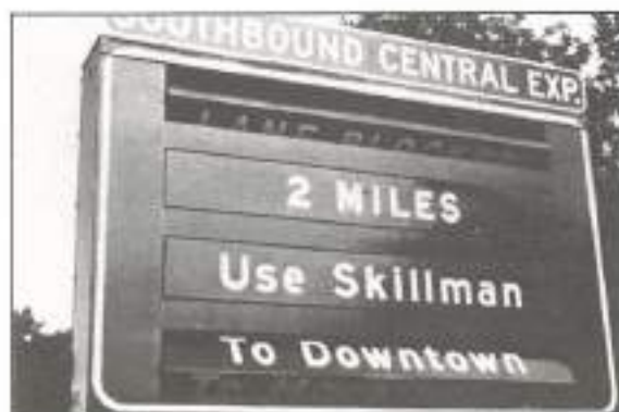
FOTO 6. Señal de prismas giratorios.
