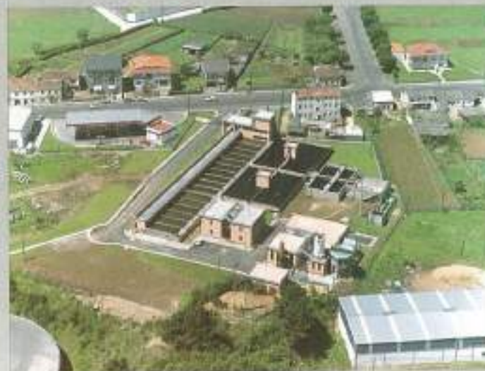
Ampliación Depuradora de Ferrol.
