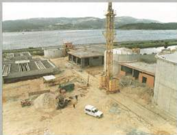
Depuradora de Pontevedra y Marín.
