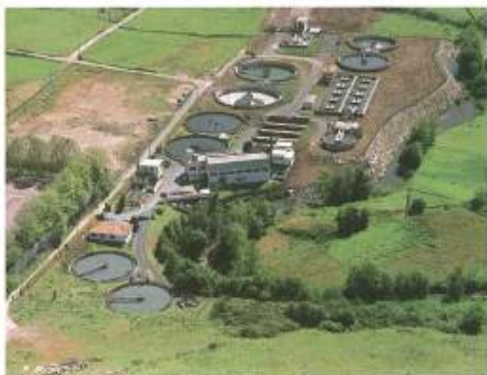
Depuradora de Santiago de Compostela.
