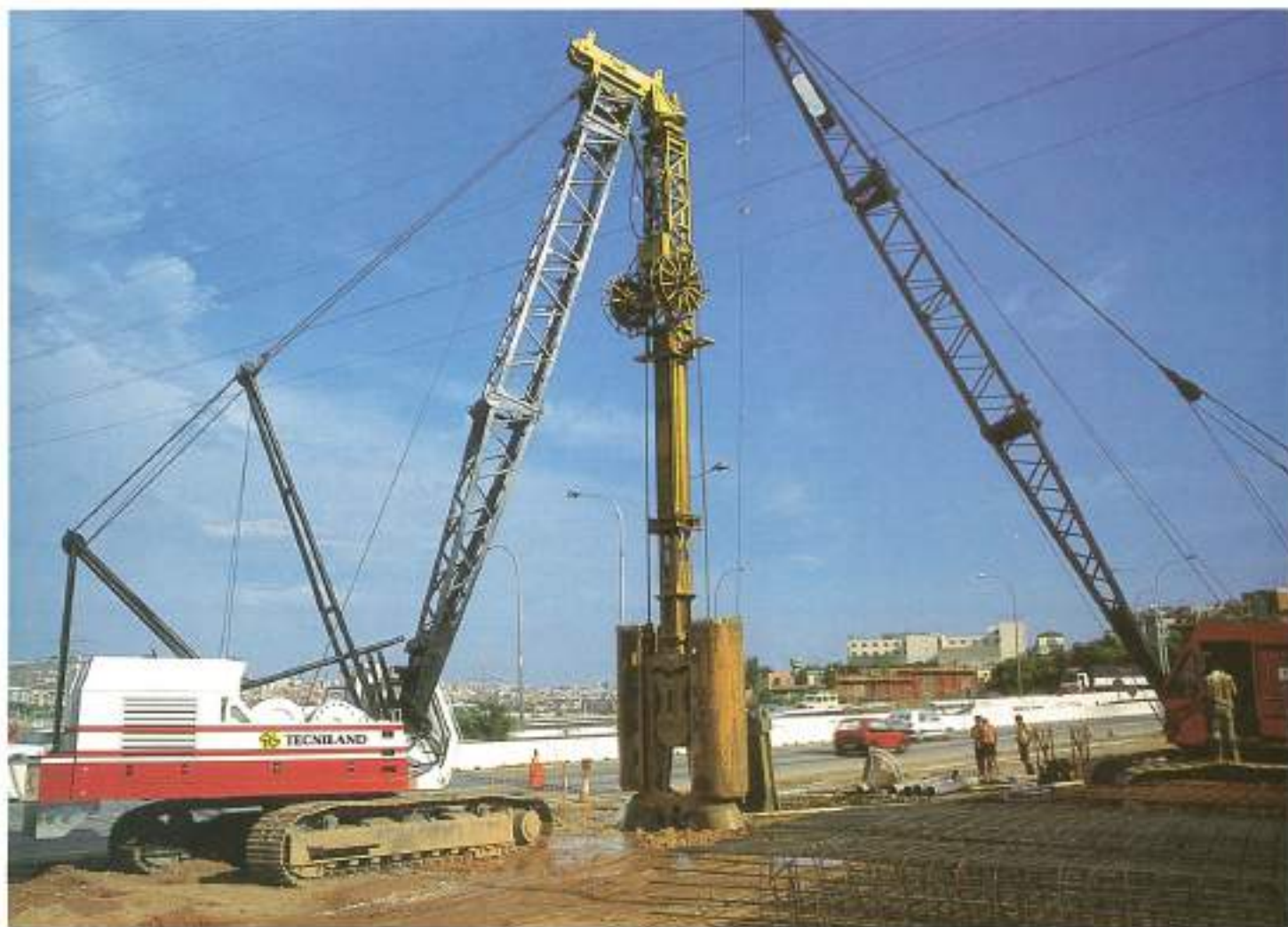
Ejecución de pantallas para cimentación del viaducto de conexión entre la autopista A-17 y el Nudo de la Trinidad, BARCELONA.
