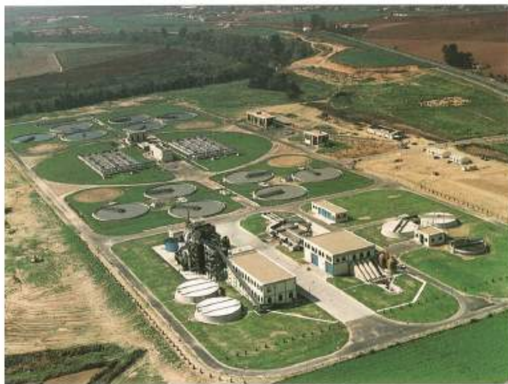
ESTACION DEPURADORA DE AGUAS RESIDUALES
