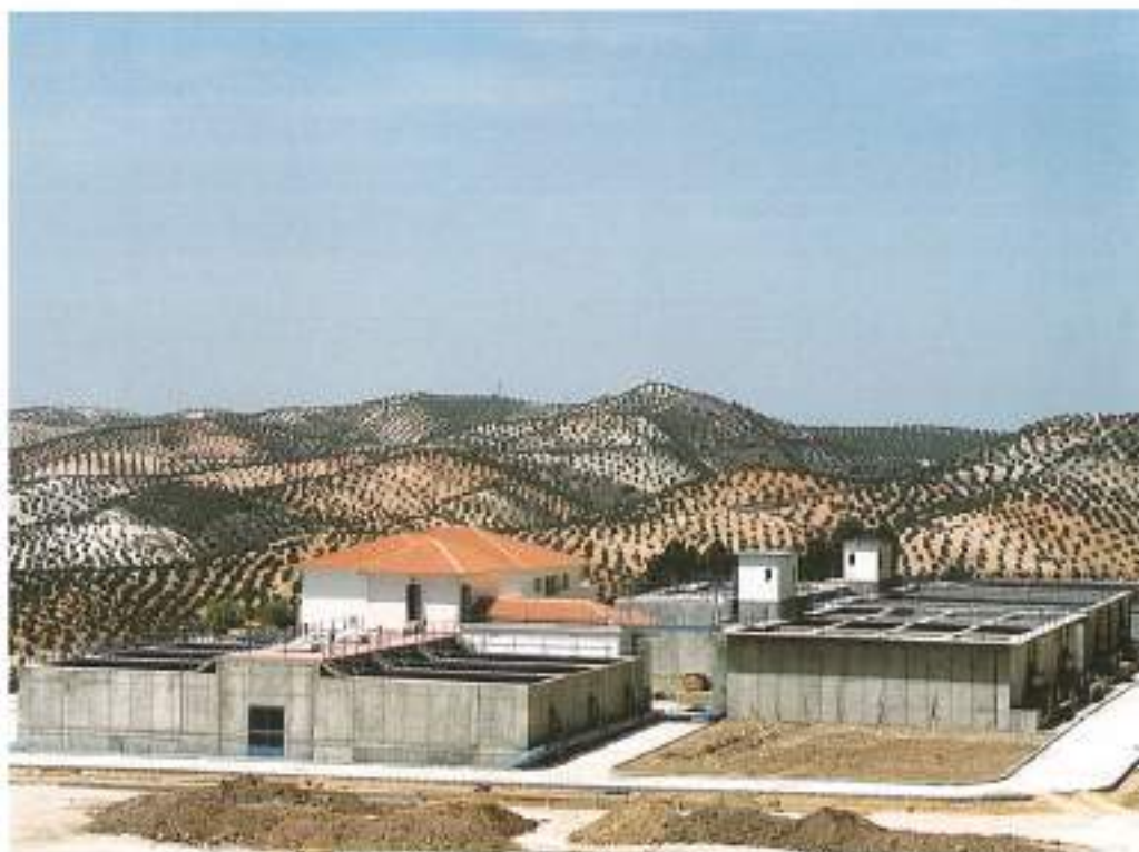
ESTACION DE TRATAMIENTO DE AGUA POTABLE
