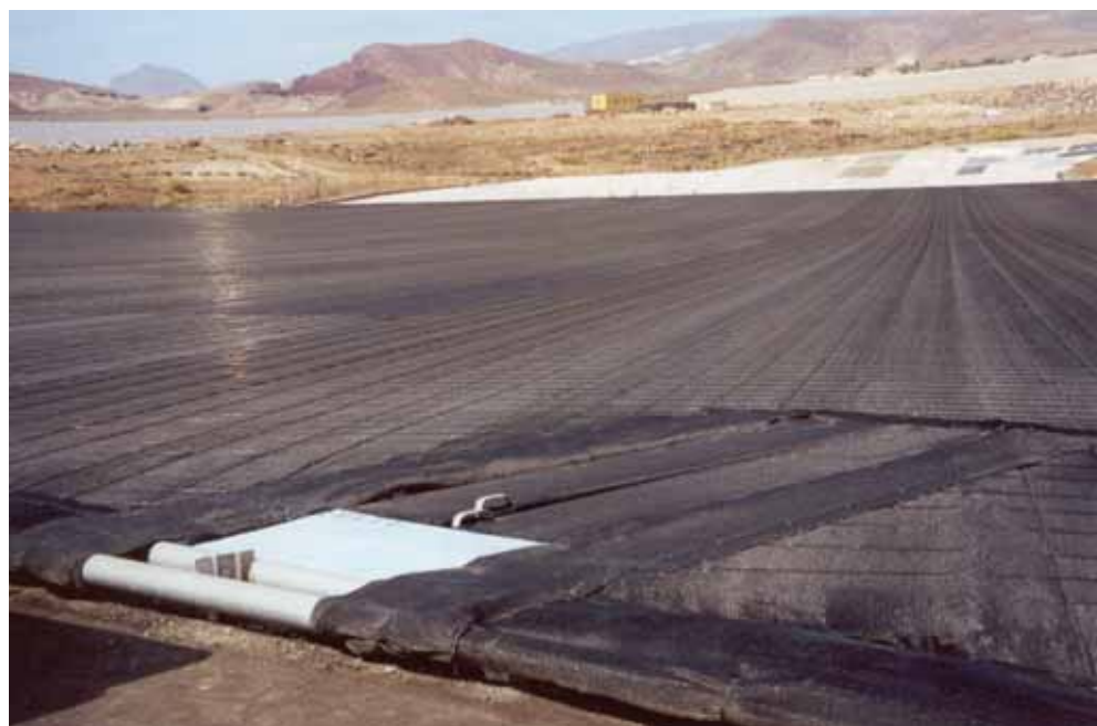
FIGURA 1. Embalse cubierto de El Saltadero, con el campo experimental al fondo.
