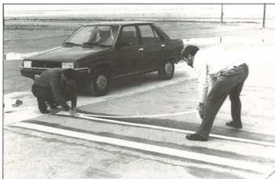
FIGURA 1. Aplicación de las cintas prefabricadas.
