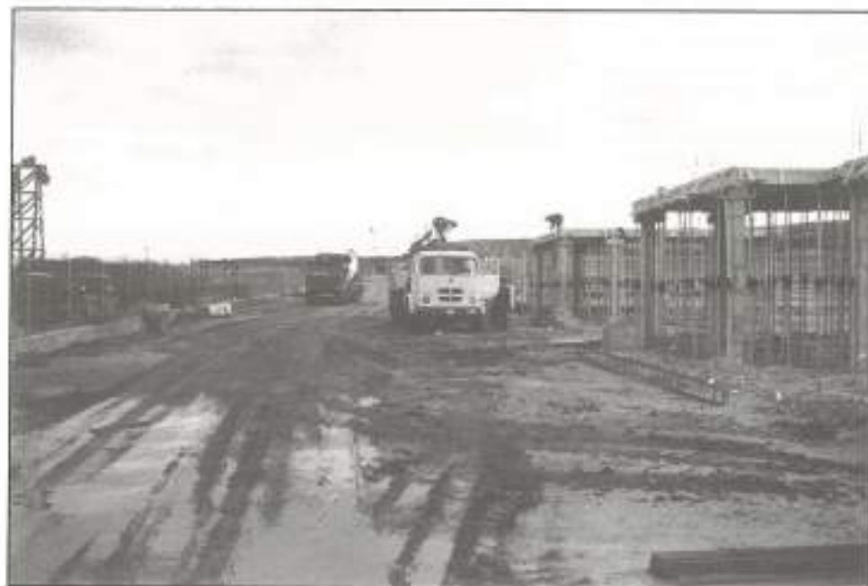
FIGURA 9. Vista de la obra de estructura y compactación de pozos.
