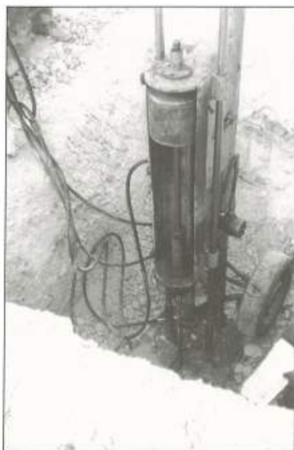
FIGURA 8. Ensayo de penetración en el propio pozo.
