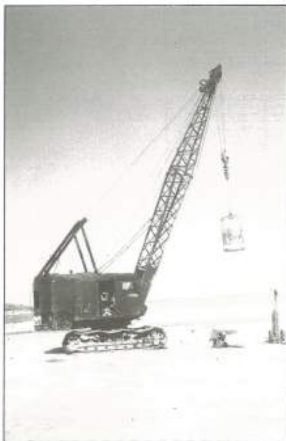
FIGURA 3. Vista de la grúa y del trabajo de compactación dinámica.
