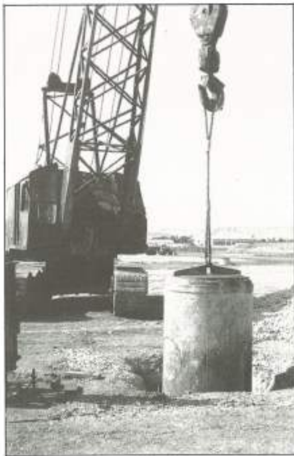
FIGURA 4. Vista de la maza utilizada en la compactación del pozo.
