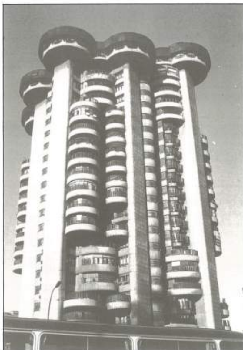
FOTO 1. Vista general del edificio Torres Blancas en la Avenida de América (Madrid), ejecutado en hormigón visto, fabricado con cemento gris y hormigonado in situ.
