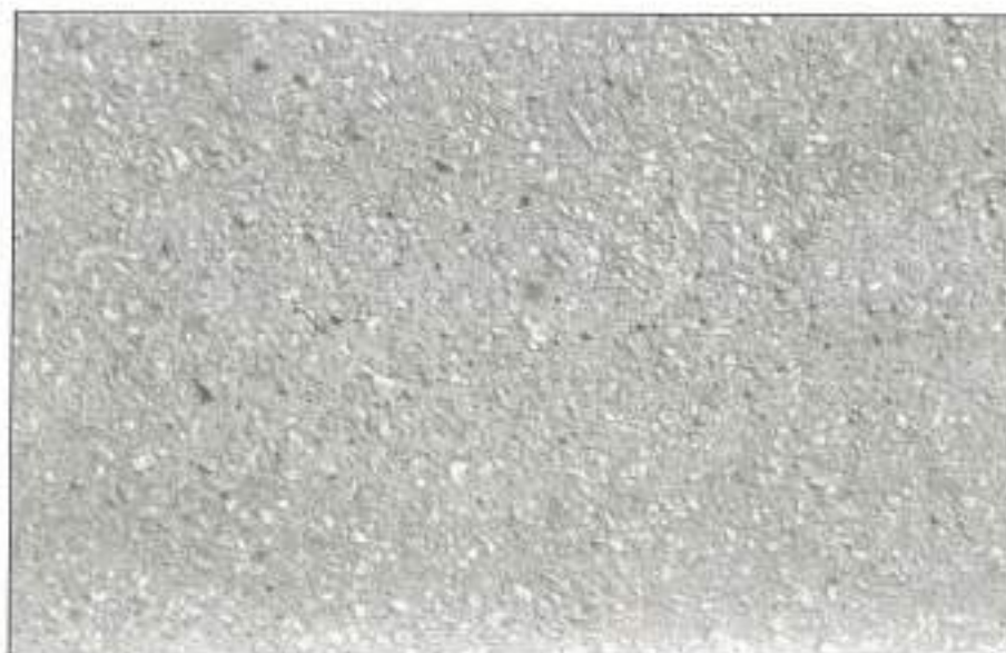
FOTO 2. Textura en árido visto obtenido mediante chorro abrasivo en los pilones de la Torre Europa, sito en el Paseo de la Castellana de Madrid.
