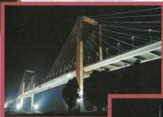
PUENTE DEL CENTENARIO - SEVILLA
