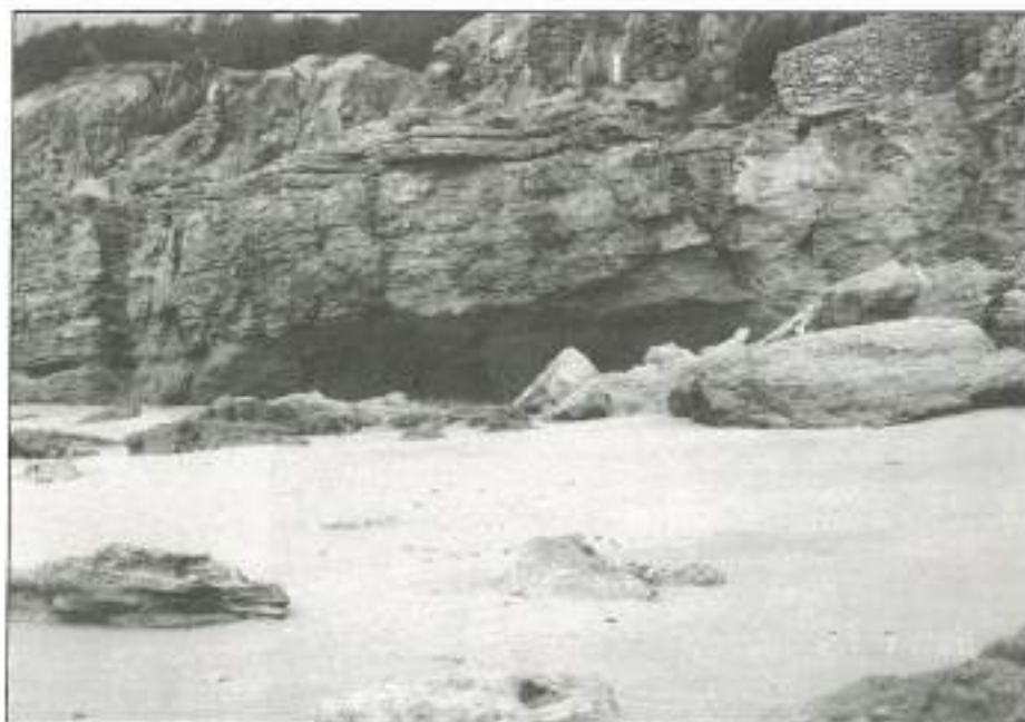
FIGURA 3. Erosión de los cantiles de Torre Bermeja.
