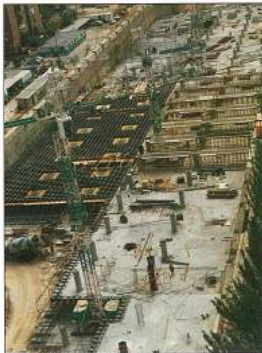
Estación nº 3, Avda. Albufera. Obra prolongación Metro L - 1.
