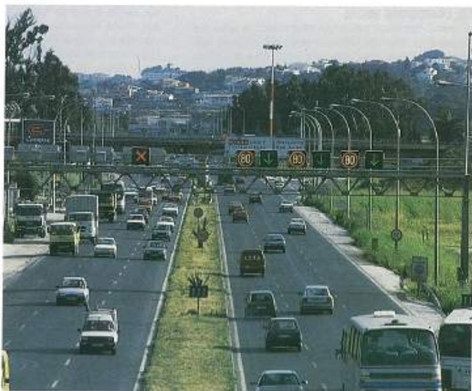
FOTO 2. Señales de fibra óptica.
