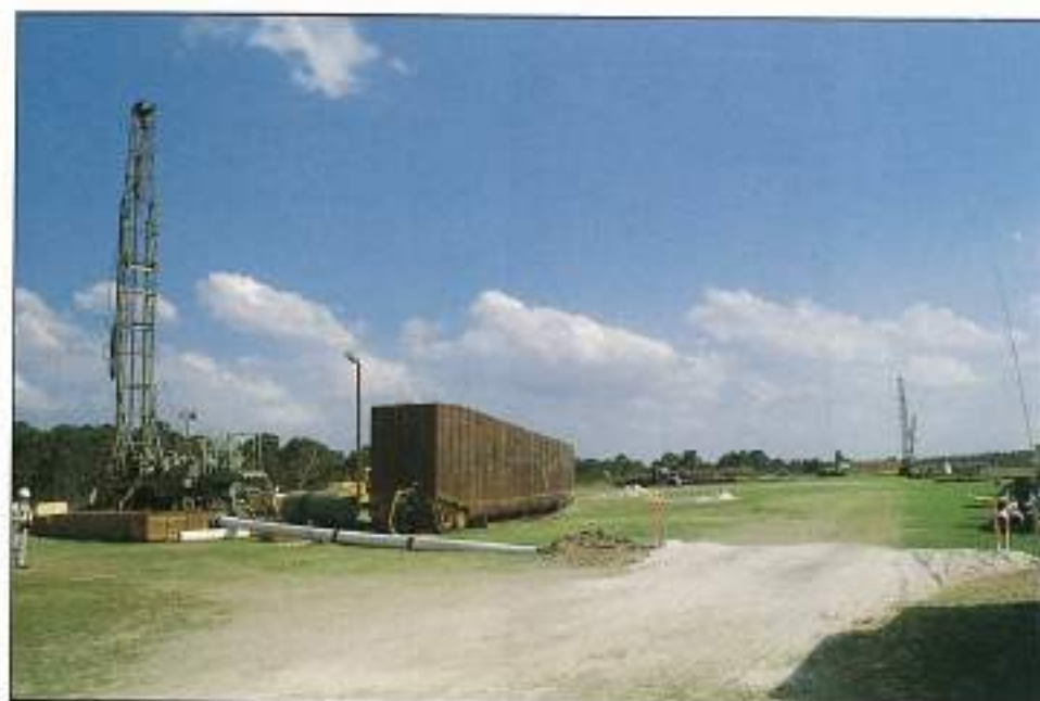
FOTO 2. Perforación de un sondeo de inyección profunda.
