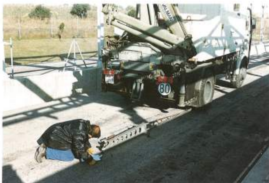
FOTO 2. Utilización de la viga Baskelman en la pista de ensayo.
