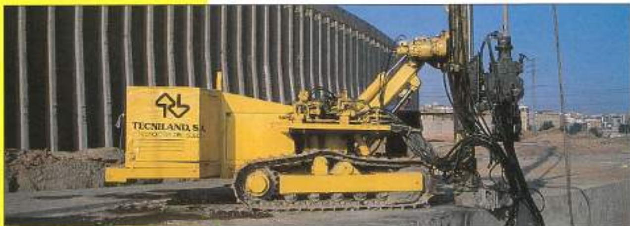
Recalce colector en el fudo de la Trinidad, Barcelona.
