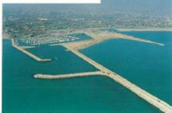
Ampliación Dársena Sur, Puerto de Valencia
