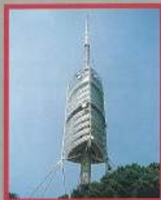
Torre de Telecomunicaciones de Colserola, Barcelona.
