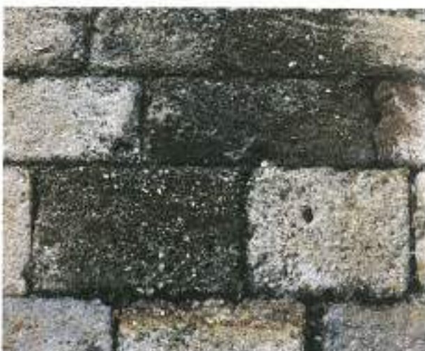
FOTO 4. Detalle de la pátina negra que se desarrolla en manchas poco extensas sobre la fábrica de sillero de los monumentos.
