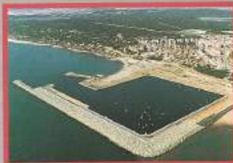
Puerto deportivo Mazagón. Huelva.
