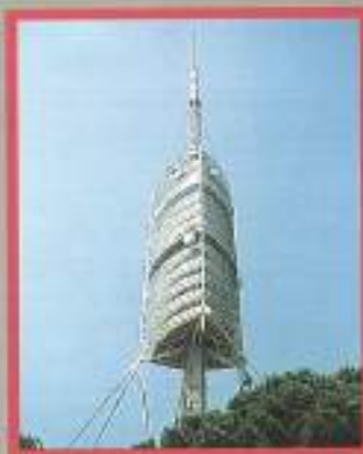
Torre de Telecomunicaciones de Colliera. Barcelona
