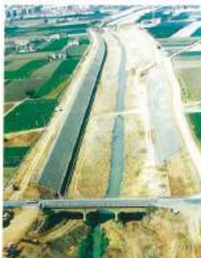
Encauzamiento del Barranco del Carrauxet.
