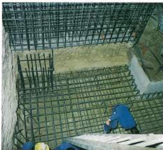
FOTO 4. Armadura del foso de la máquina.
