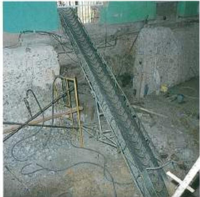
FOTO 3. Obras de cimentación y del foso de la máquina de  $10.000 \text{ kN}$ .
