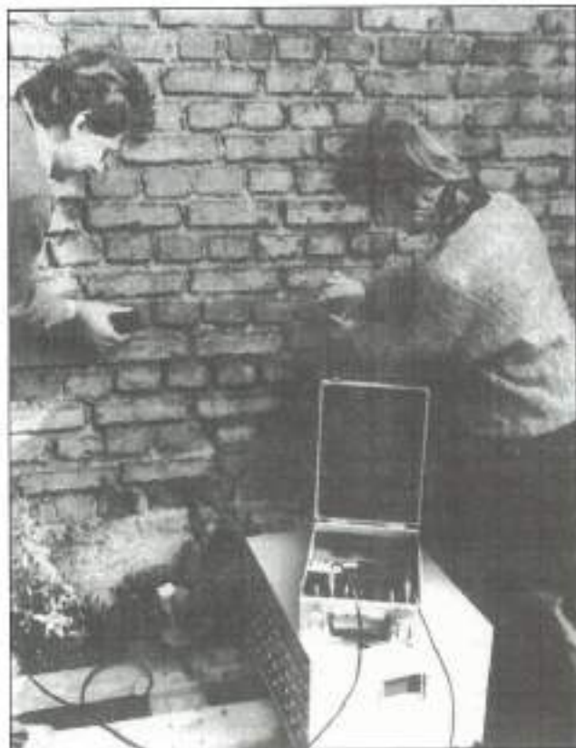
FIGURA 3. Medida de velocidad de propagación del sonido en fábrica de ladrillo (5MES).
