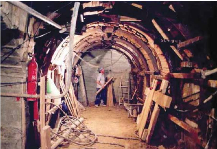
FIGURA 14. Galería de hastial (Estación de Guzmán el Bueno).
