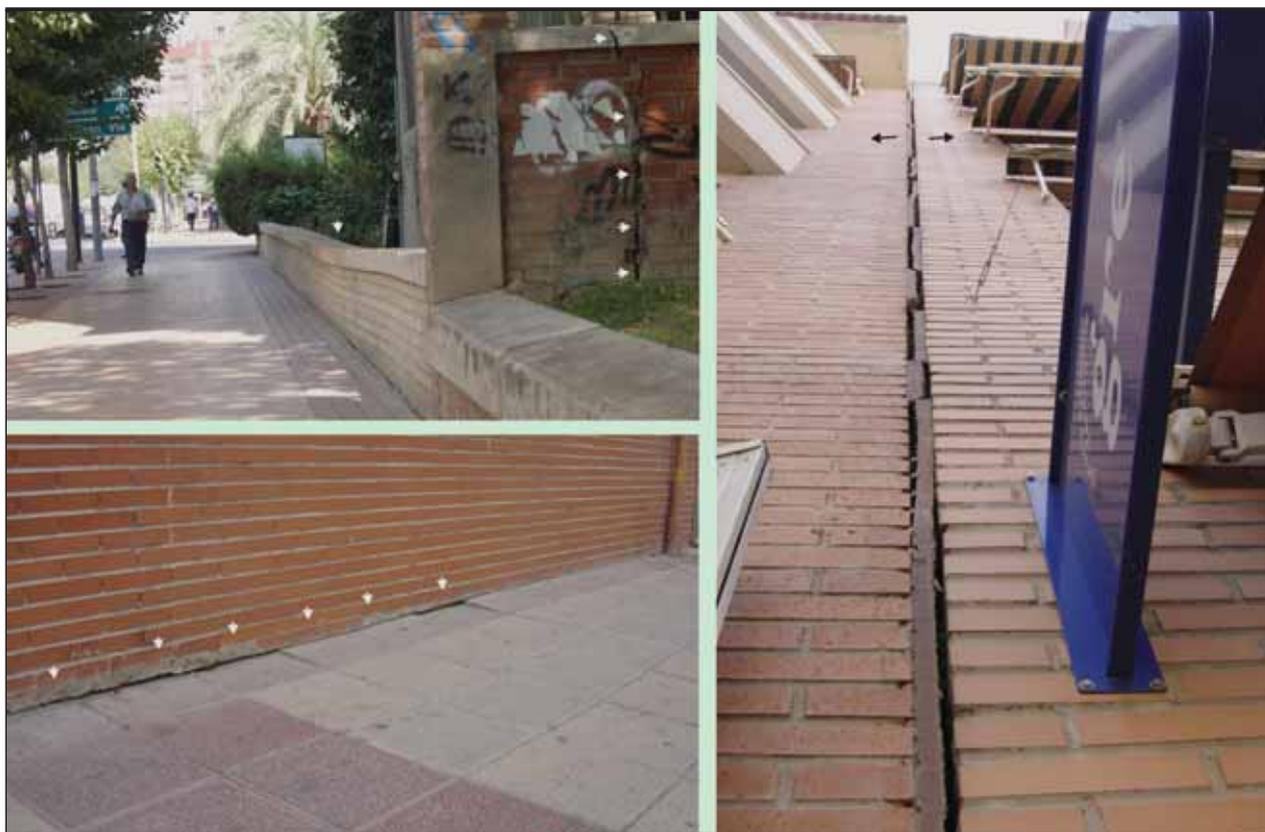
FIGURA 2. Efectos de la subsidencia observados en algunos elementos urbanos de la ciudad de Murcia (deformación de aceras y apertura de las juntas medianeras).
