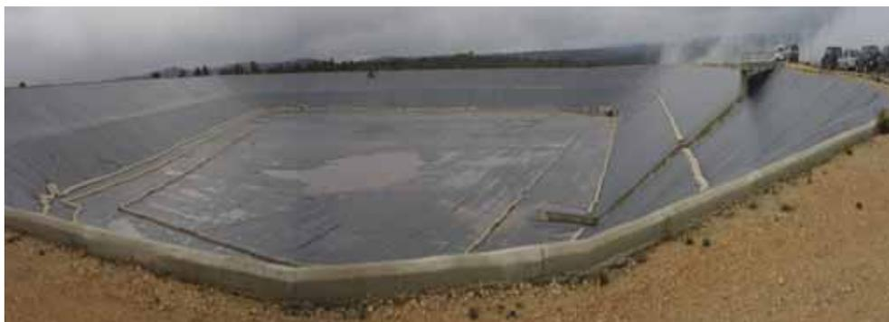
**FIGURA 3.** Balsa de Calderones (Valencia) impermeabilizada con PEAD.
