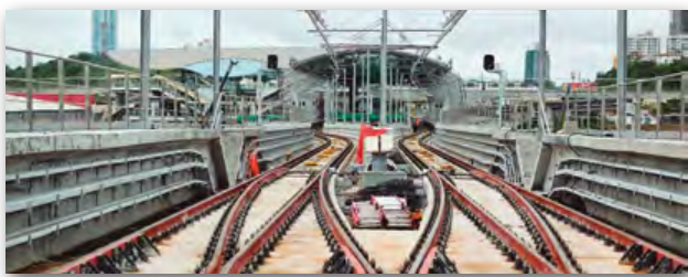
Figura 14. Playa de vías salida de estación.
