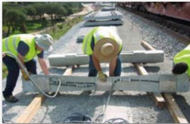
**Figura 30.** Instalación de células de presión bajo las traviesas.
