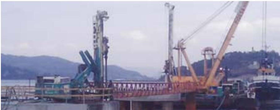
FIGURA 23. Perforación de los micropilotes.
