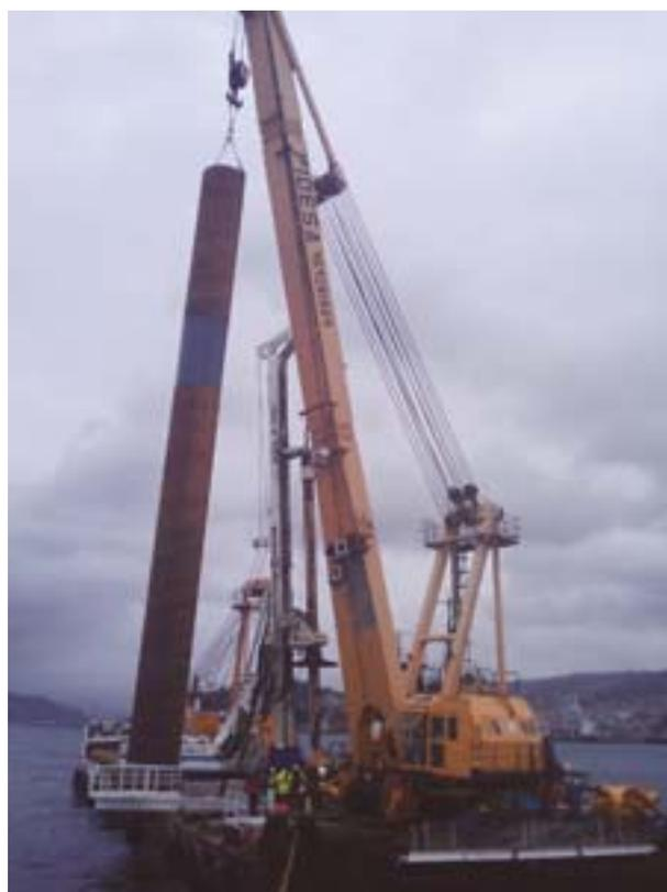
FIGURA 16. Colocación de la tubería en la plataforma auxiliar.
