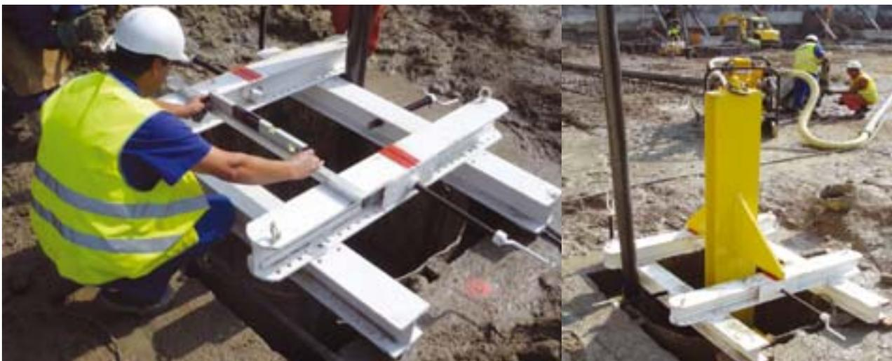
**FIGURA 16 y 17.** Prolongador. Nivelación de la estructura centradora y pilar colocado, antes de retirar el prolongador de cuelgue.
