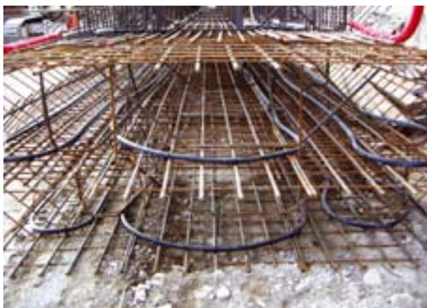
FIGURA 21. Armadura montada con las sondas geotérmicas.
