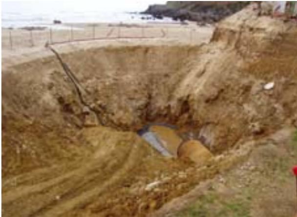
FIGURA 10. Vista general de la duna tras la recuperación de los dos primeros módulos de la microtuneladora.
