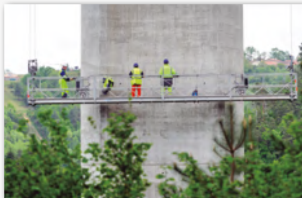
Figura 2. CEREMA cuenta con la pasarela Epsilon, un dispositivo innovador diseñado para realizar la inspección, mantenimiento y reparación de todo tipo de puentes, reduciendo así el impacto sobre el tráfico rodado. Fotografía Arnaud Bouissou – Terra.
