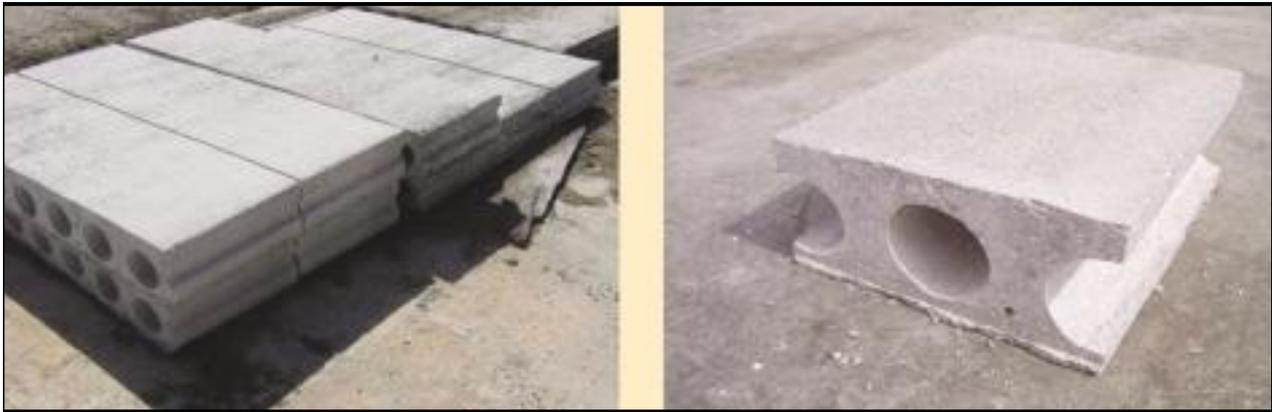
FIGURA 3. Cortes de piezas de losas prefabricadas.
