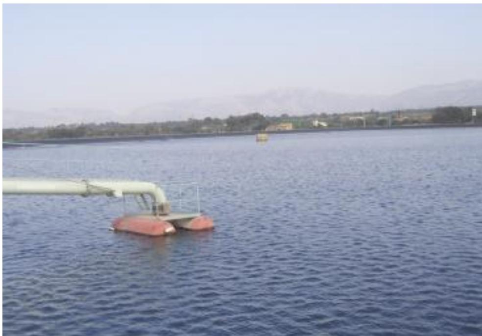
**FIGURA 3.** Toma de agua flotante.
