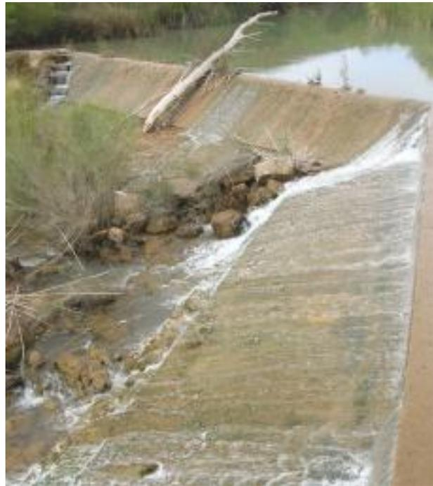
FIGURA 9. Erosión en la base de un azud. Río Mundo (Albacete).
