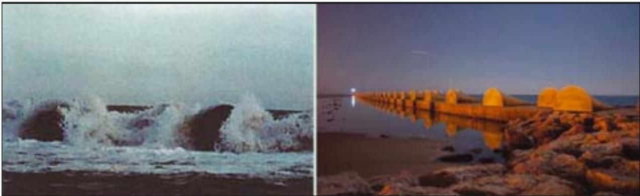
FIGURA 6. Control de la agitación del mar por el dique de Cubelles (Barcelona) (Izda.) y detalle del dique (Dcha.).
