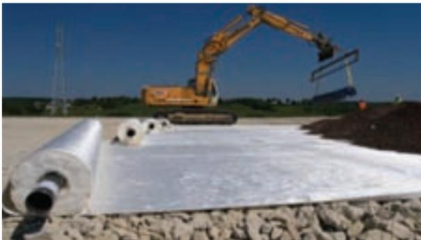
FIGURA 5. Colocación del geotextil.
