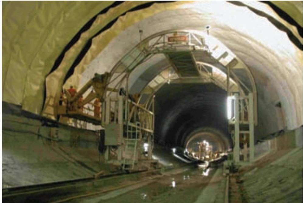
**FIGURA 8.** Geosintéticos utilizados en túneles. /
