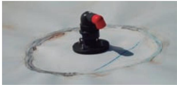
FIGURA 6. Aireador instalado en la cubierta flotante.
