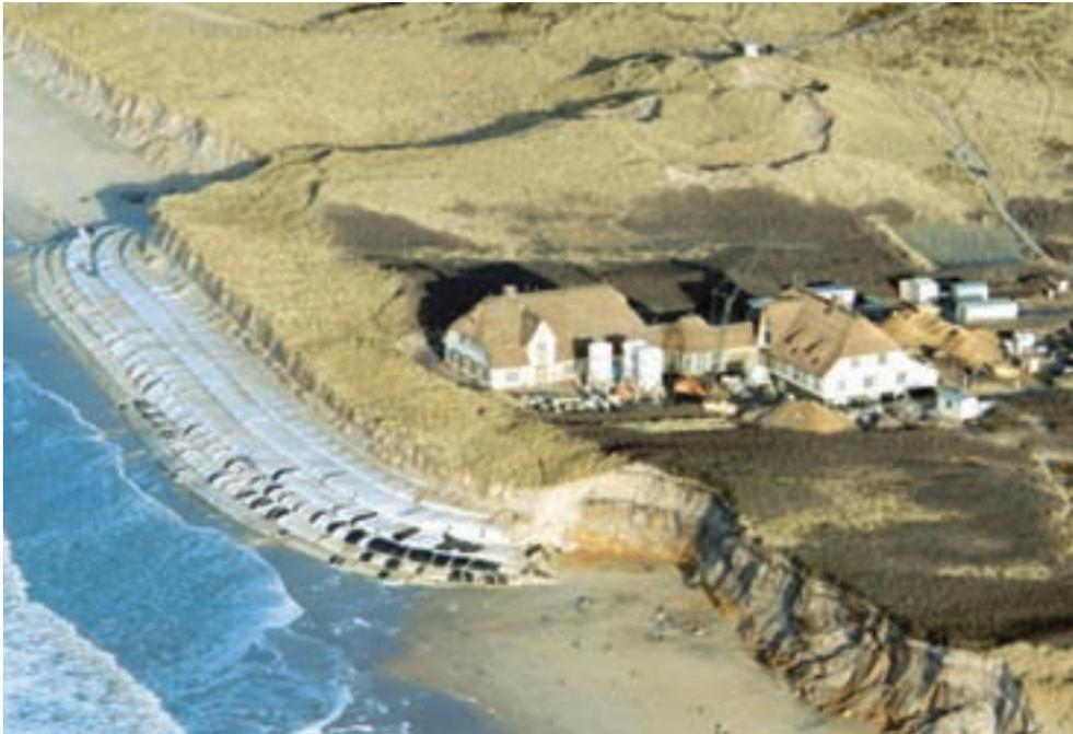
**FIGURA 10.** Geocontenedores utilizados para protección de la costa. / **FIGURE 10.** Geosynthetics containers used for coastal protection.
