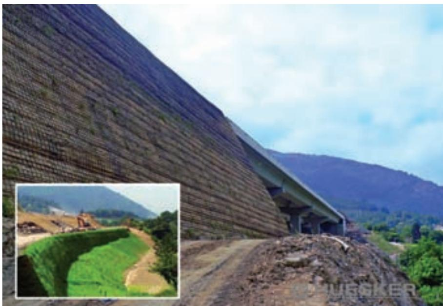
**FIGURA 4.** Muro verde reforzado con geomalla utilizado como estribo de un puente. /
