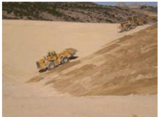
FIGURA 9. Extendido de la mezcla.
