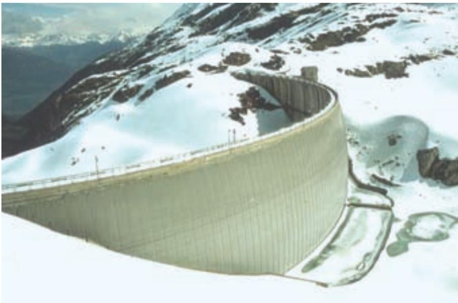
FIGURA 1. Presa de hormigón rehabilitada con geosintéticos. /
