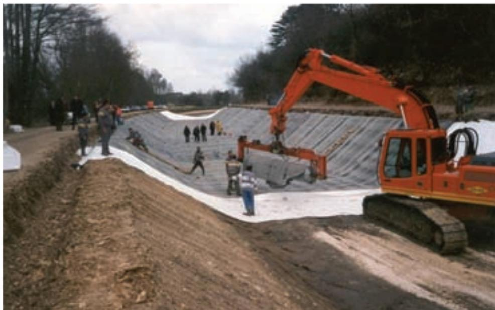
FIGURA 3. Canal revestido con una geomembrana y un geotextil. /
