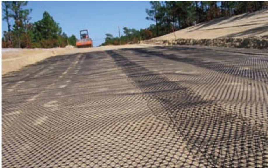
**FIGURA 6.** Geomalla utilizada como refuerzo en la base de una carretera. / **FIGURE 6.** Geogrid used for road base reinforcement.
