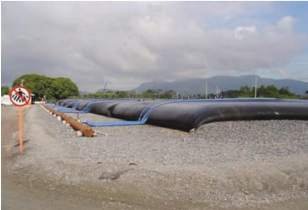
**FIGURA 9.** Geotubo para decantado de sedimentos contaminados. /
