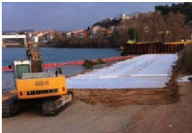
FIGURA 5. Detalle desenrollado del geosintético de refuerzo.
