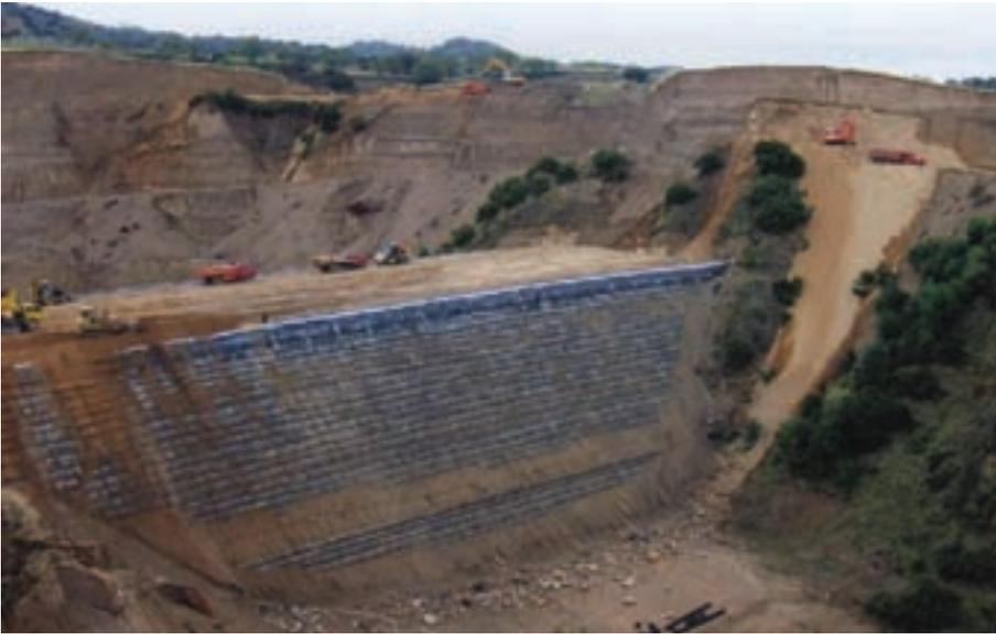
FIGURA 5. Vertedero tras un terraplén reforzado con un geosintético. /
