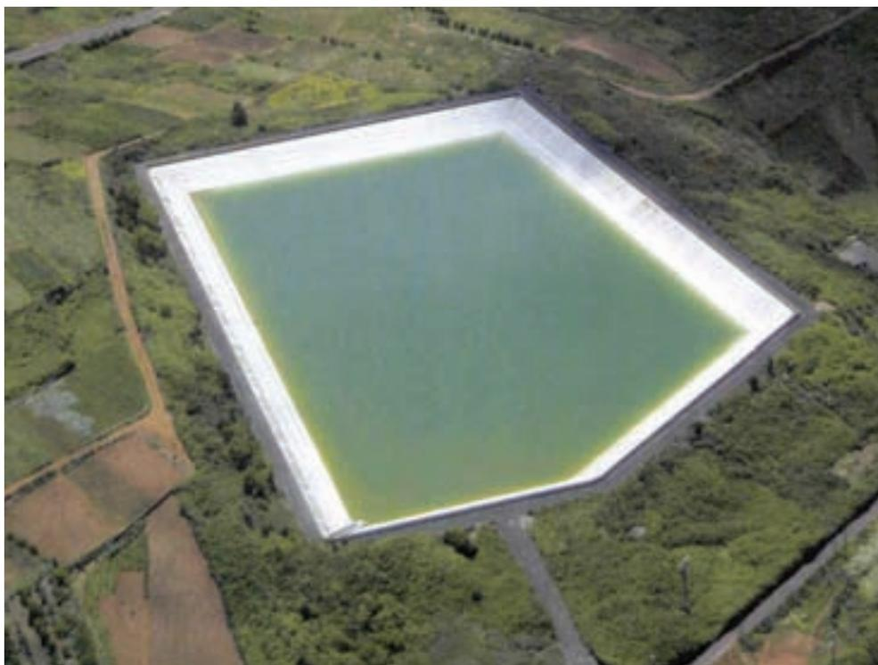
FIGURA 1. Balsa de Los Llanos de Mesa impermeabilizada con una geomembrana de PVC-P.
