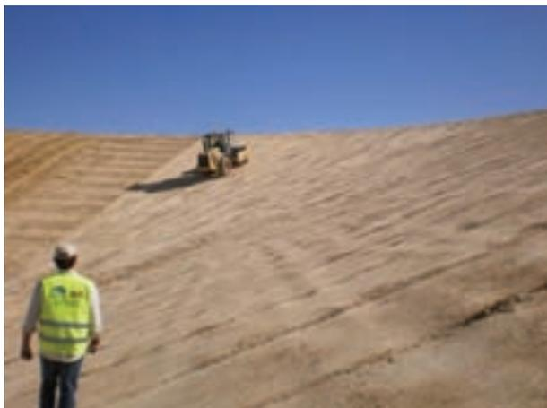
FIGURA 10. Compactado de la mezcla.
