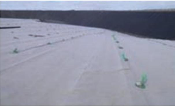
FIGURA 12. Instalación del sistema de drenaje para lixiviados en la mina de Kanmantoo, Australia.
