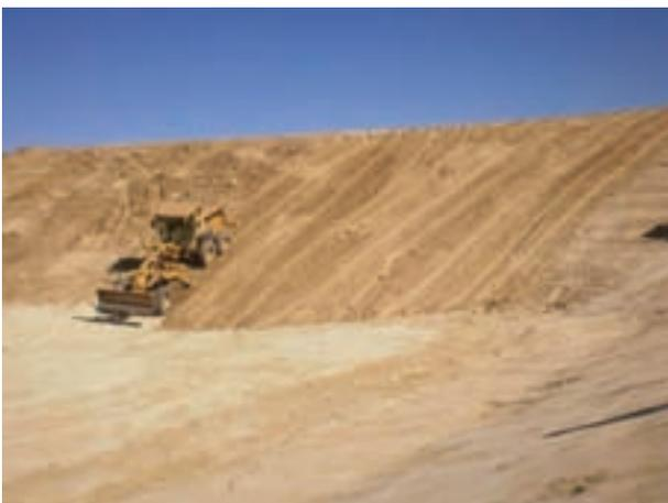
FIGURA 8. Extendido de la mezcla.
