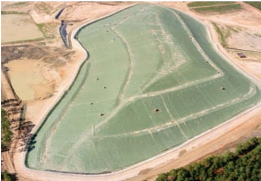
**FIGURA 7.** Sellado de un vertedero mediante una geomembrana. / **FIGURE 7.** Exposed geomembrane landfill cover.
