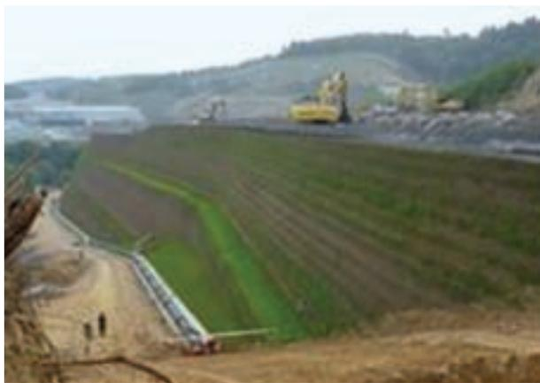
FIGURA 7. Muro verde formado por un terraplén reforzado de 30 m de altura en Bilbao, España.
