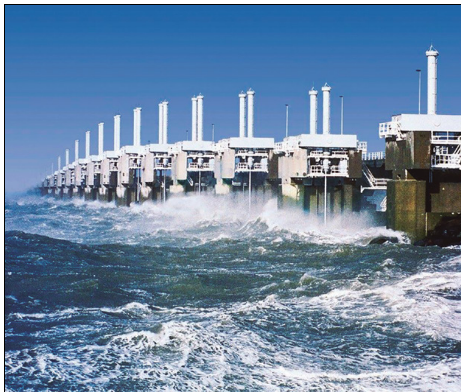
Figura 2. Sistema de compuertas del OosterSchelde.
