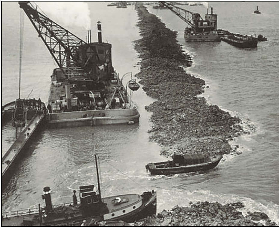
Figura 10. Obras de construcción del dique Afsluitdijk.
