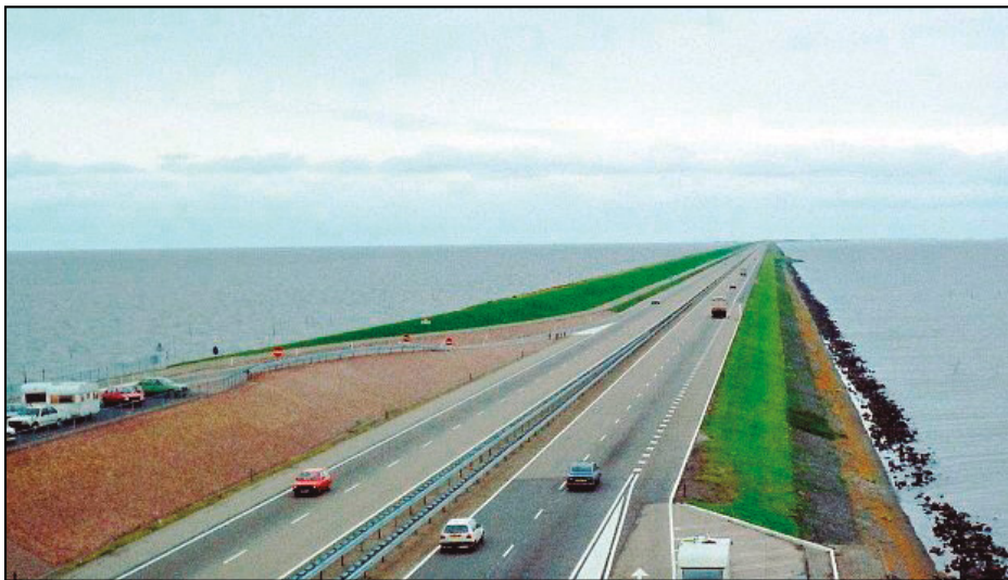
Figura 11. Vista del Dique de Afsluitdijk separando las aguas del Mar de Wadden (saladas) de las aguas del lago IJsselmeer (dulces).
