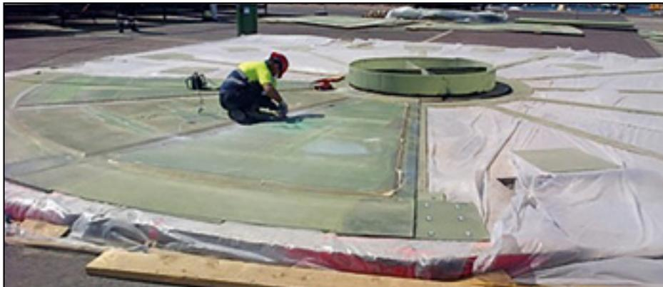
**Figura 5.** Montaje de las piezas de la base del cajón.
