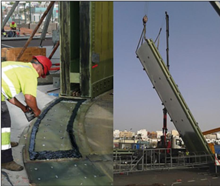
**Figura 6.** Aplicación adhesivo en lavase del cajón para la posterior unión con un módulo vertical (izquierda). Izado de uno de los módulos verticales. Mediante grúa (derecha).
