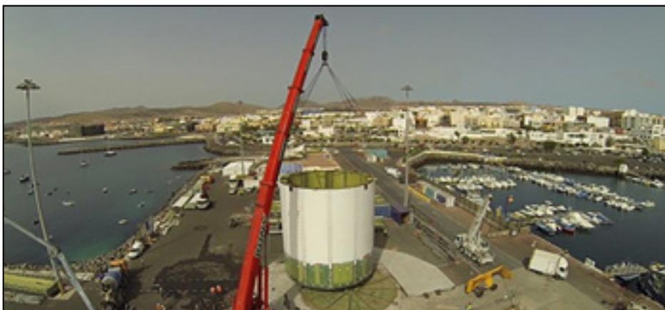
**Figura 8.** Izado del cajón completo instantes antes de proceder a su botadura.
