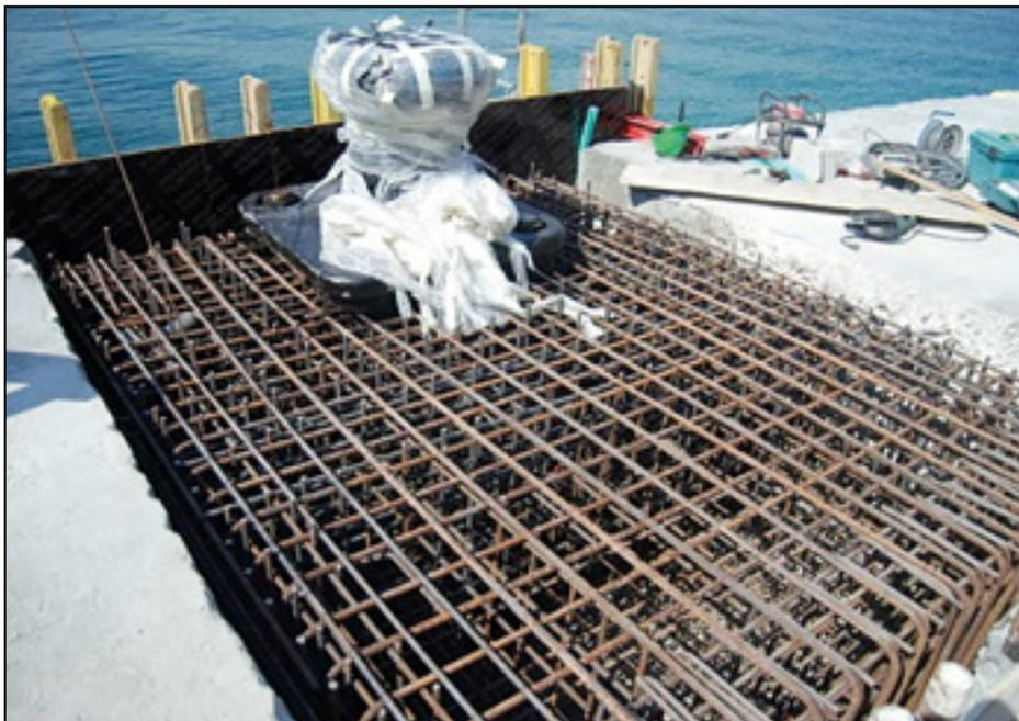
Figura 6. Macizo de apoyo fuertemente armado.
