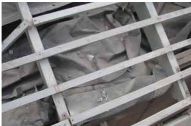
FIGURA 14. Capa plástica bajo los listoncillos de apoyo, reteniendo trozos de asbesto-cemento no retirados por los sistemas de extracción.
