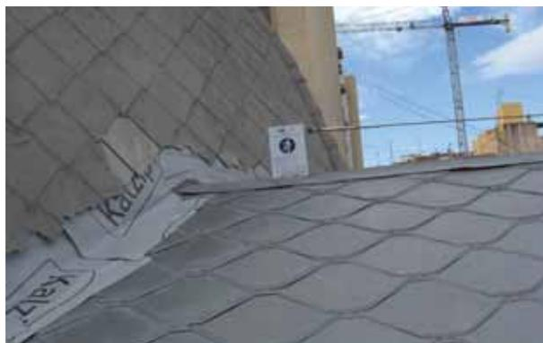
FIGURA 15. Placas de asbesto-cemento adheridas por la impermeabilización en la cúpula (izquierda), y nuevas escamas de zinc romboidales (derecha).
