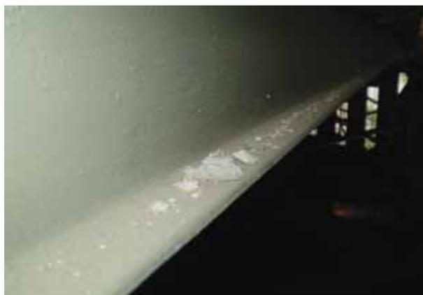
FIGURA 16. Trozos de asbesto-cemento no retirados por los sistemas de extracción, depositados sobre la estructura metálica.
