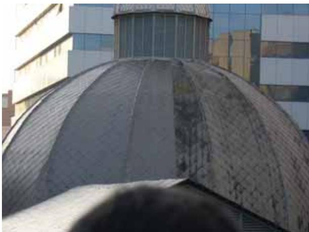
FIGURA 6. Placas de asbesto-cemento en cúpula. A la izquierda se aprecia la capa adicional de impermeabilización.
