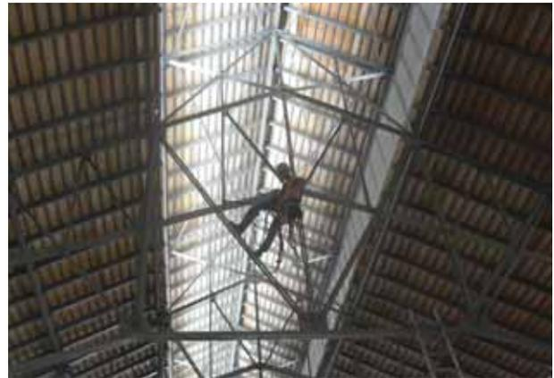
FIGURA 18. Operario de Trabajos Verticales, realizando tareas de tratamiento de la estructura de acero.
